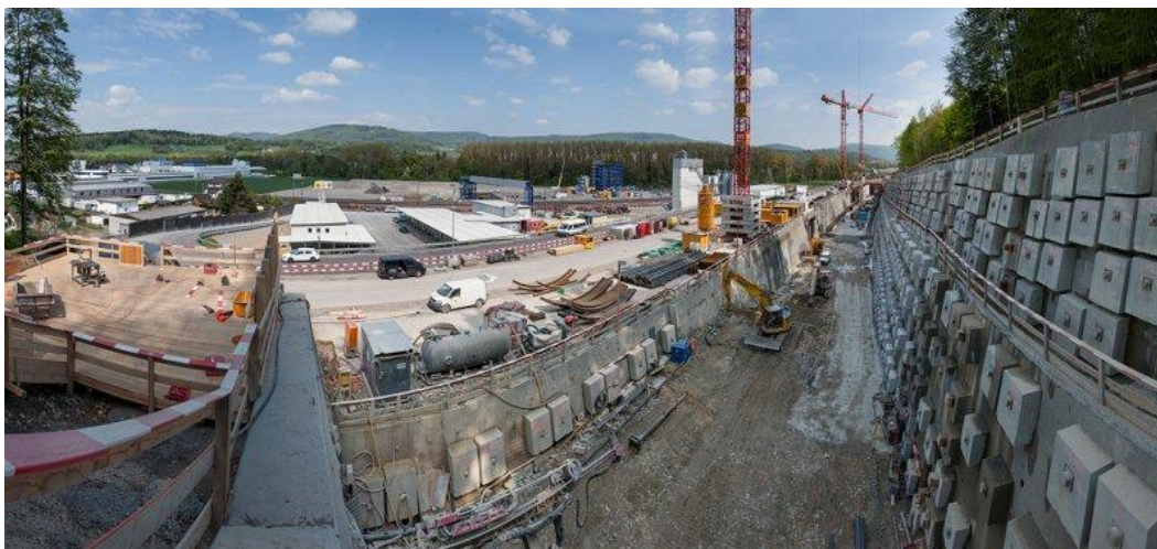
Baustellenführung Vierspurausbau Olten - Aarau (Eppenbergtunnel)
